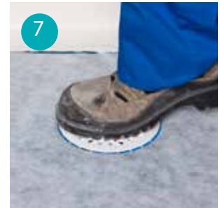
7 Sätt fast klämringen på brunnsilen och tryck till den så att den snäpper i läge. Kontrollera att ringen är i rätt läge.
