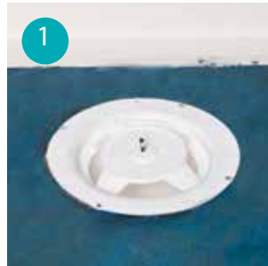
1 Montera foten till puruskniven
