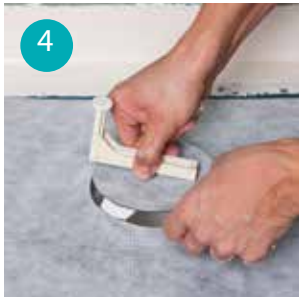
4 Skär upp hålet och ta bort knivfoten, kniven och manschettbiten. OBS! Använd rätt håll i puruskniven.
