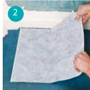
2 Centrera Brunnsmanschetten över golvbrunnen och montera den.
