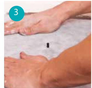
3 Gnid fast manschetten noga, se till att den inte får några blåsor eller veck.
