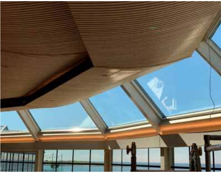
Spaltribbade välvda tak i etager med belysning blev en vacker och effektiv akustiklösning på restaurang Titus Tapas, Hotel Tylösand.
