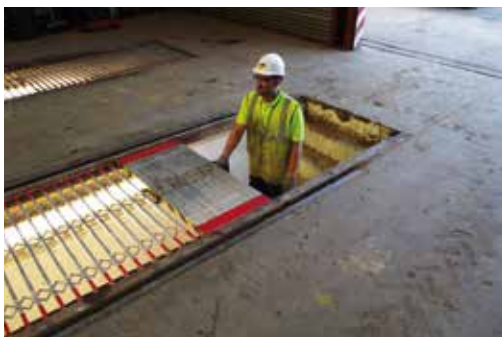
Öppna skyddets ände för att komma ner i gropen via trappan.
