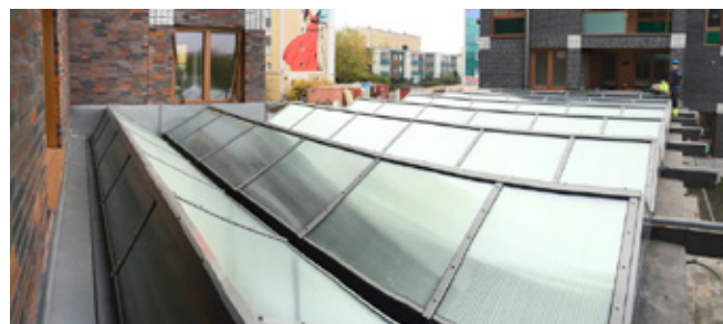
Sågtandtak glasat med polykarbonat över flerbostadshusets gemensamma vinterträdgård. Holma Torg Malmö, Arkitektlaget Helsingborg.
