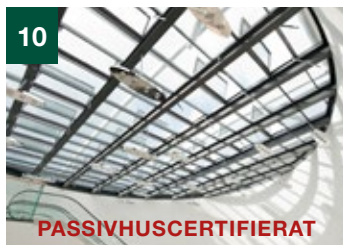
GLASTAKSYSTEM U_{TOTAL} ner till 0,81 W/m 2 K (1,2 x 2,5 m)
