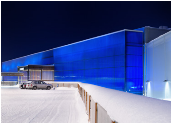
Väderskydd kring byggnaden släpper in lagom med dagsljus och lyser upp omgivningen kvällstid.
