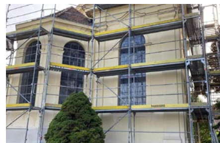
Steg 3 – Montage av ställning
