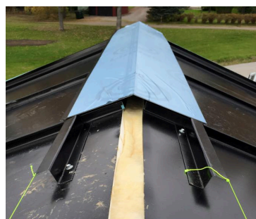
Figur 4, Nockplåt monterad på Z-profil
