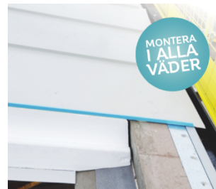
Figur 1 Takelement kan monteras även i nederbörd
