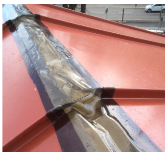
Figur 5, 3M Fast-UC monterad
