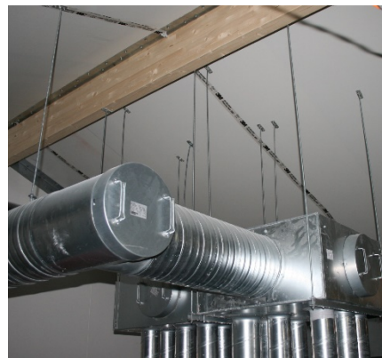
Figur 8, Upphängning av ventilation i Takelement.
