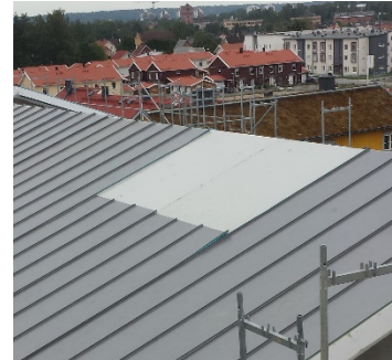
Figur 2 Takelement anpassat för kompletterande arbeten
