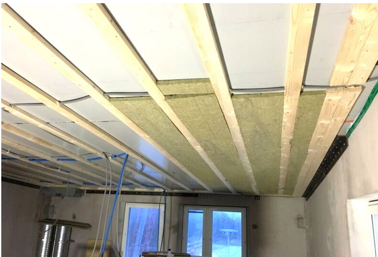
Bild 3, Exempel på innertak med kompletterande stenull för att förbättra ljud och brandegenskaper.
