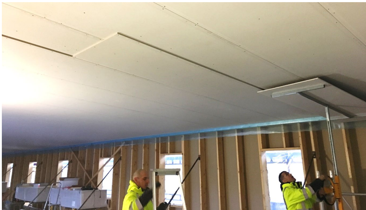
Bild 1, Installation av dubbelgips direkt mot takelementets underplåt.
