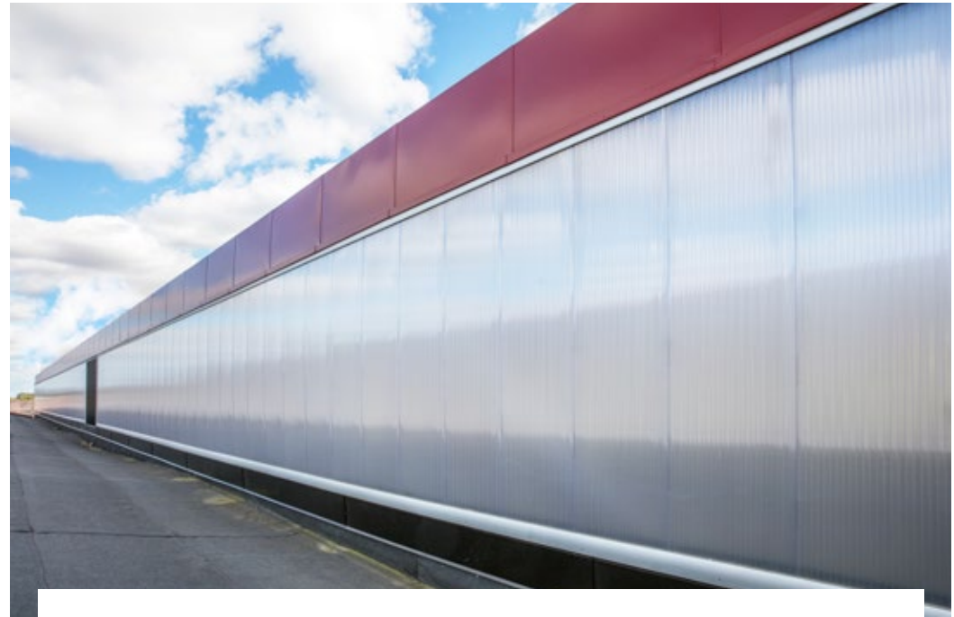
Infällda paneler som ljusband i den gamla byggnaden ger ett mildt och balanserat ljus till lokalerna.
