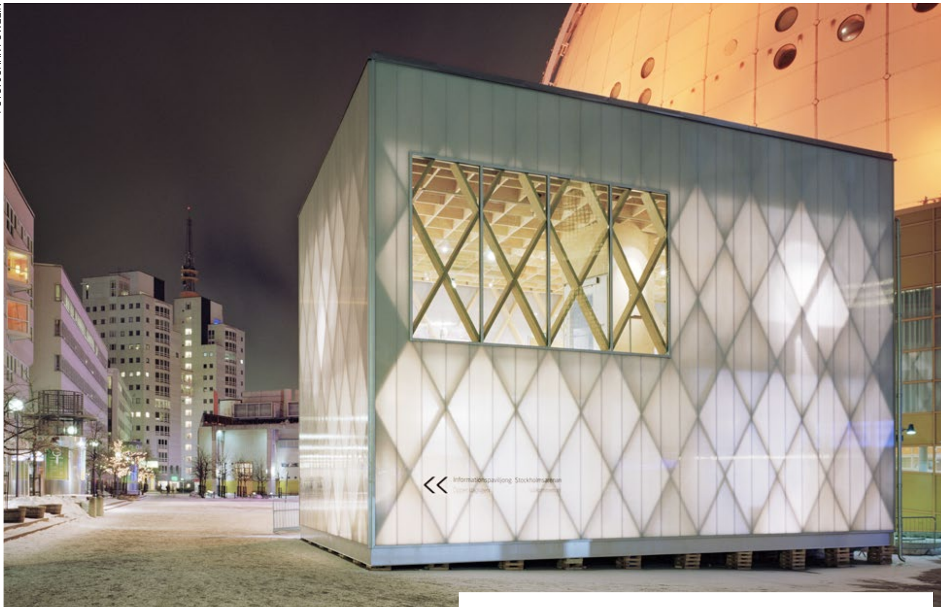
Ett temporärt informationscenter under byggandet av Stockholmsarenan. Paviljongen med regler i x-struktur och paneler i opal och bakomliggande belysning för effektivt uttryck.
