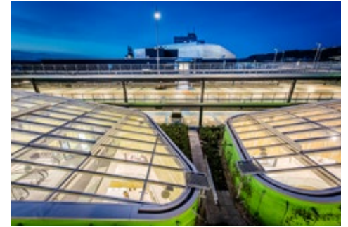
Passivhuscertifierat glastak med unik profiluppbyggnad.
