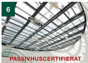
GLASTAKSYSTEM U_{TOTAL} ner till 0,81 \text{ W/m}^2\text{K} (1,2 x 2,5 m)
