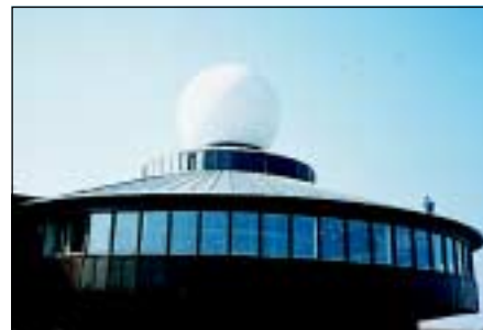
Kafé Kompass, Nordkap 550 m 2 takduk från Protan med profiler på Nordens mest väderutsatta byggnad!
