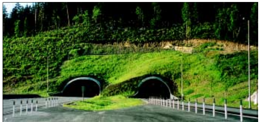
Vinterbro - Vassum, tunnel E6, Norge
