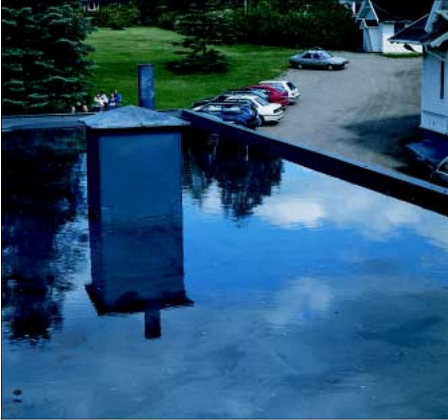
Henie-Onstad Konstsenter, Hövik 2700 m 2 membran från Protan under betongplattor
