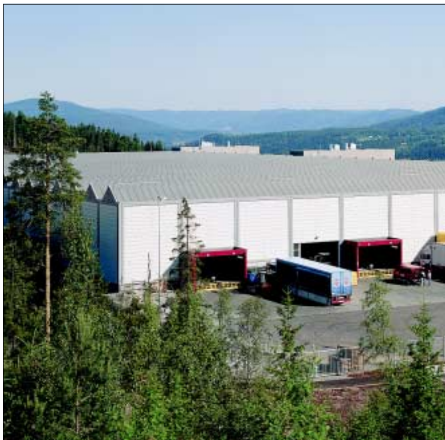
Ringnes Bryggeri, lager och distributionsanläggning, Oslo 40000 m 2 profiltäckning från Protan. Ark. Astrup & Hellern.
