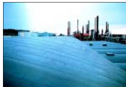
Esso Norge A/S, Slagentangen, Tønsberg 5 500 m 2 takduk från Protan är lagd på välvda tak 1985
